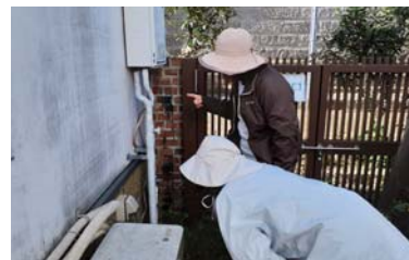
■ 空き家管理サービスの様子
